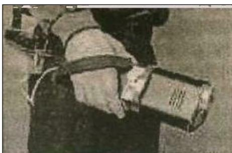
Рис.4.7. Детектор паров ВВ «МО – 2» с встроенным пробоотборником [10]
